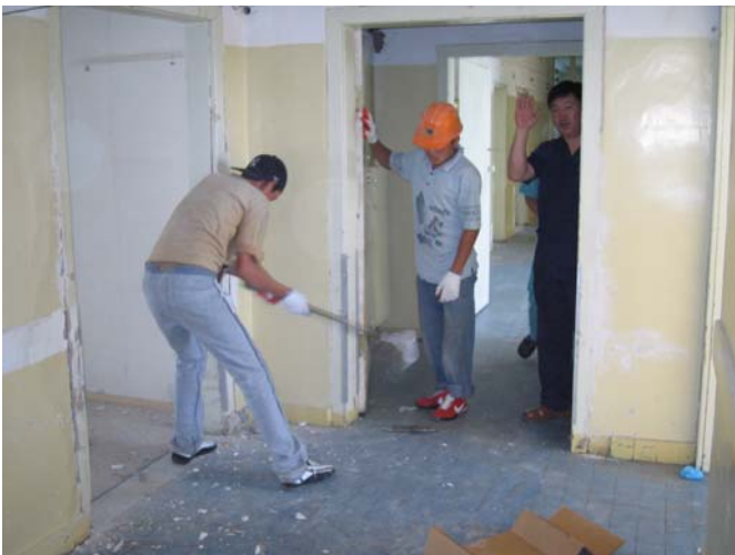
Erster Spatenstich – in diesem Fall Hammerschlag – die ersten Wände fallen!
